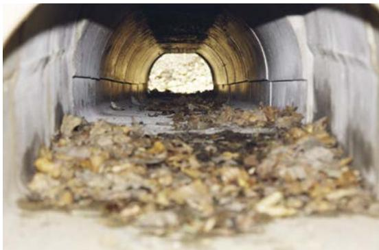
Figure 72a – Le tunnel est équipé de puits de lumière et a un diamètre suffisamment large pour limiter l'entretien dans le temps dû à la sédimentation de la poussière et des matières organiques de l'environnement (source: wegenbouw.be).
