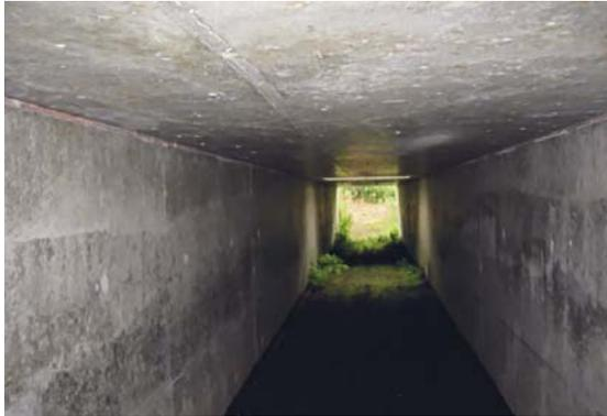
Figure 71 – Exemple d'un tunnel (pour les grands animaux) sous l'infrastructure. Ce tunnel a un puit de lumière au milieu. De cette manière, il fait moins sombre et le tunnel semble plus court. Par conséquent, malgré sa longueur, il convient aux chevreuils et aux sangliers.
