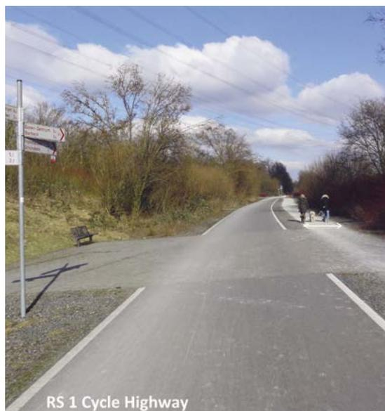
Figure 19b – La partie piétonne et la partie cycliste sont séparées l'une de l'autre par une berge centrale et un marquage linéaire – Exemple en Allemagne, RS1. © Joris Van Damme
