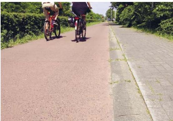
Figure 34 – Séparation piste cyclable/trottoir à Bruges, Belgique. © Projet CHIPS
