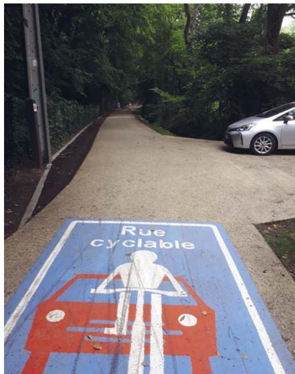
Figure 60 – Exemples de revêtements en zone naturelle: Gand, Schipperskaai (pavés + béton); Genk, Wintergroenstraat (stabilisé avec liant naturel); Rue de la Malaise, Ottignies (béton coloré délavé).
