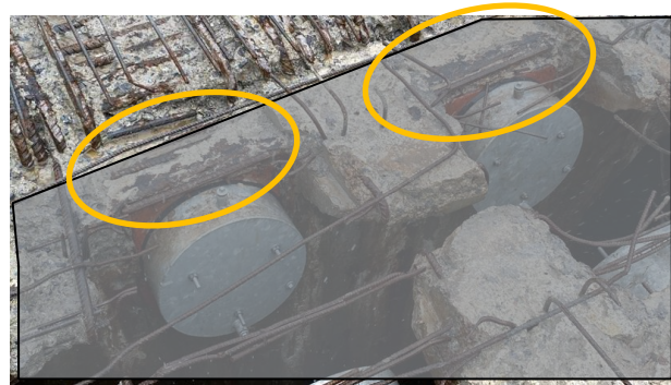
Figura 280 Detalle debloques de pretensado sobre pila P3, a la izquierda, tras picado de losa de continuidad y sobre pila P1, tras la demolición de la losa y el saneado del hormigón. A destacar la escasa distancia entre los bloques con casi 6000 kN respecto al borde superior libre. Placa de anclaje casi enrasada con el propio paramento superior de la losa. Sombreado en gris, la zona "inerte" correspondiente a las losas de continuidad (ver sección marcado en figura inferior
