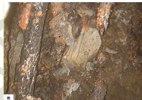
Figura 80 Detalles del interior del cordón de pretensado en donde se observa claramente la rotura por corrosión de los cordones del pretensado. Fuente: Esteyco
