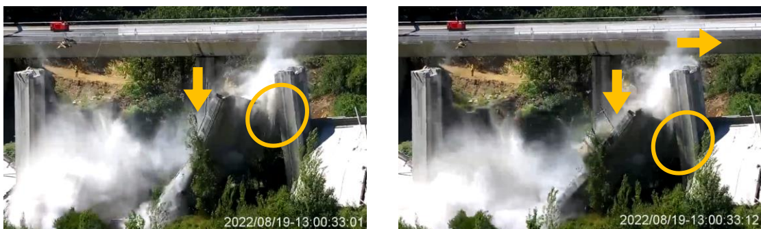
Figura 128 Contacto con el terreno de la primera mitad del tablero. Caída semi-vertical del segundo tramo. Fuente imagen: DGT
