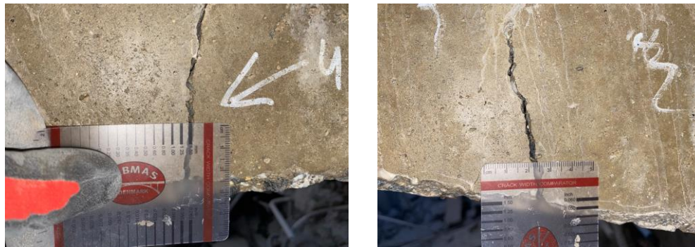
Figura 143 Vano 1. Mamparo 2. Medición de fisuras en interior de mamparo de hasta 2,5-3,0 mm aproximadamente.
