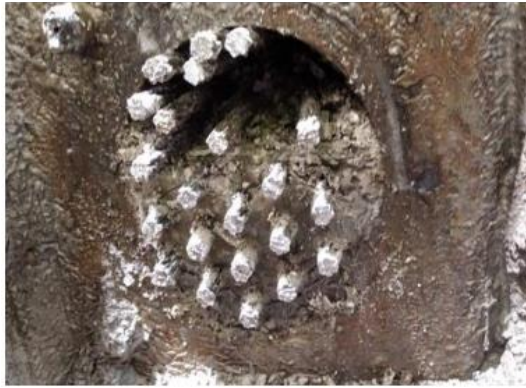
Figura 269 Detalles del interior de bloques de pretensado, con importantes defectos de protección por la lechada detectados durante la fase de "autopsia" y sustitución selectiva de 17 cables. Fuente: Freyssinet
