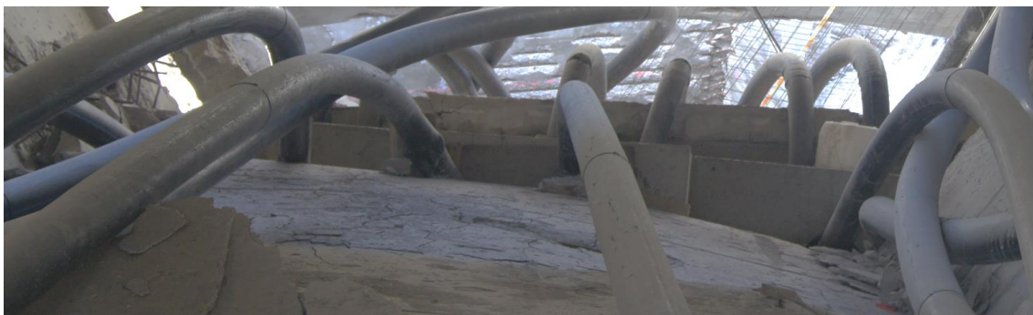
Figura 201 Vano 1. Desviador D5. Vista general. Aparente integridad del mismo y de su vinculación a las almas de la dovela.
