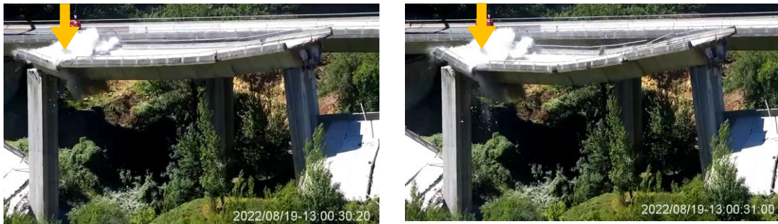
Figura 124 Giro y descenso tramo corto. Fuente imagen: DGT
