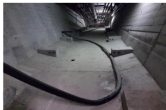
Figura 33 A la izquierda, vista general del puente l'Île de Ré con el encabezado de prensa en donde se da la noticia de la rotura de un cable del postesado. A la derecha, vista general del interior del puente con el cable roto.
