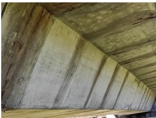
Figura 48 Filtración de agua, eflorescencias, lajaciones, manchas de óxido en las juntas entre dovelas y almas del cajón
