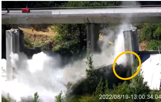
Figura 129 Caída completa del tablero deslizando/rozando sobre el alzado de pila P2. Final de la demolición controlada del vano. Fuente imagen: DGT
