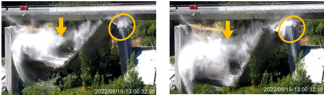
Figura 127 Continuación de caída a plomo de tramo extremo y central. Pérdida de contacto del tramo extremo a P2 con cabeza de pila. Fuente imagen: DGT
