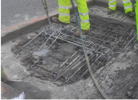
Figura 55 Vista general de zona reparada durante el saneo realizado en 2020. Fuente: COPASA
