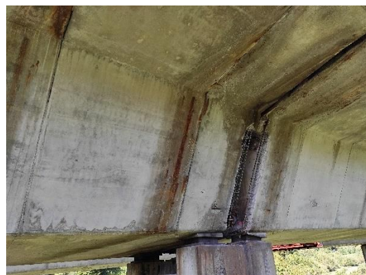
Figura 48 Filtración de agua, eflorescencias, lajaciones, manchas de óxido en las juntas entre dovelas y almas del cajón
