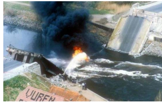
Figura 32 Colapso del puente Malle en Bélgica (1992) por el fallo por corrosión del pretensado interior.
