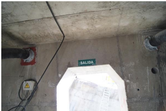
Figura 135 Vano 1. Mamparo 1. Vista interior del paso de hombre. Sin daños aparentes.
