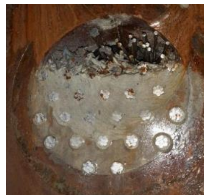
Figura 81 Detalles del interior de bloques de pretensado, con importantes defectos de protección por la lechada detectados durante la fase de “autopsia” y sustitución selectiva de 17 cables. Fuente: Freyssinet
