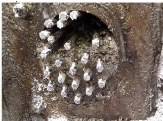
Figura 81 Detalles del interior de bloques de pretensado, con importantes defectos de protección por la lechada detectados durante la fase de “autopsia” y sustitución selectiva de 17 cables. Fuente: Freyssinet
