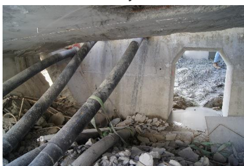
Figura 158 Vano 2. Mamparo 1. Vista general del interior del mismo. Aparente integridad estructural del mismo y sin grandes desórdenes a simple vista.
