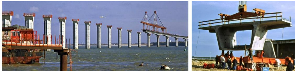
Figura 28 Vista general del puente de l'Île de Ré en fase de construcción y, a la derecha, una de las casi 800 dovelas que forman la estructura, todas ellas con geometría variable adaptada al trazado y canto.
