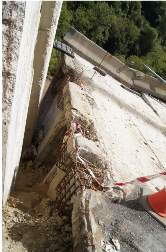
Figura 173 Vano 2. Mamparo 2. Vista general exterior desde el lateral izquierdo.
