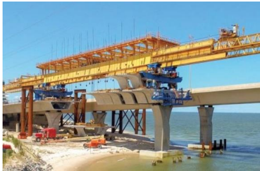
Figura 42 Ejemplos de soluciones constructivas mediante vigas lanzadoras de dovelas en fase constructiva
