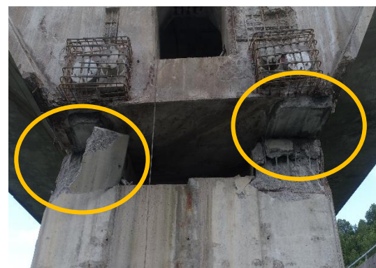
Figura 119 Detalle de cara inferior de tacones de apoyo del vano V2 sobre P2. Ausencia de indicios de daño por rozamiento.
