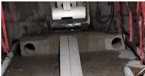
Figura 89 Detalle de tacón de desvío/refuerzo en el frente de los estribos ejecutados para los cables de refuerzo
