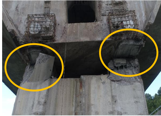
Figura 287 Detalle de cara inferior de tacones de apoyo del vano V2 sobre P2. Ausencia de indicios de daño por rozamiento.
