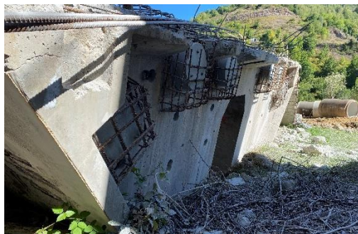
Figura 157 Vano 2. Mamparo 1. Vista general exterior desde el lateral izquierdo. Integridad aparente del mismo.
