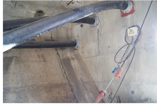
Figura 134 Vano 1. Mamparo 1. Vista interior del lateral derecho. Sin daños aparentes.
