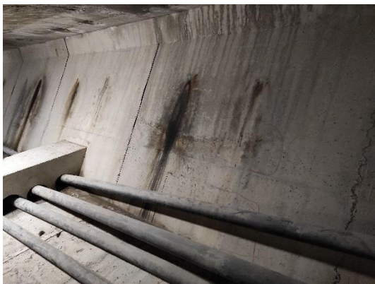
Figura 47 Humedades, manchas de óxido y desconchones en el alma en zonas bajo pasatubos
