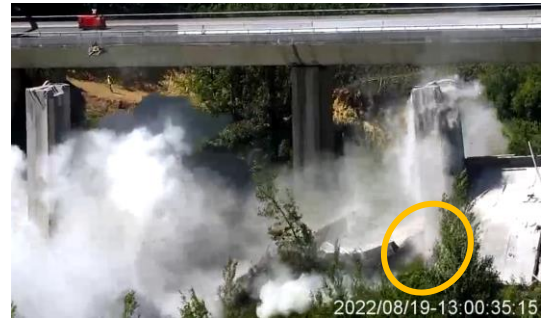
Figura 129 Caída completa del tablero deslizando/rozando sobre el alzado de pila P2. Final de la demolición controlada del vano. Fuente imagen: DGT
