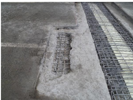
Figura 95 Detalle de reconstrucción de losa en 2013. Fuente: COPASA
