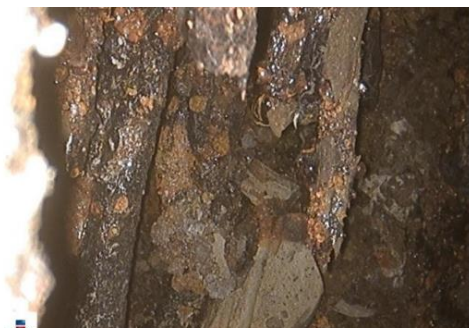
Figura 80 Detalles del interior del cordón de pretensado en donde se observa claramente la rotura por corrosión de los cordones del pretensado. Fuente: Esteyco
