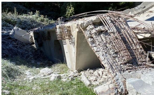
Figura 156 Vano 2. Mamparo 1. Vista general exterior desde el lateral derecho. Integridad aparente del mismo.
