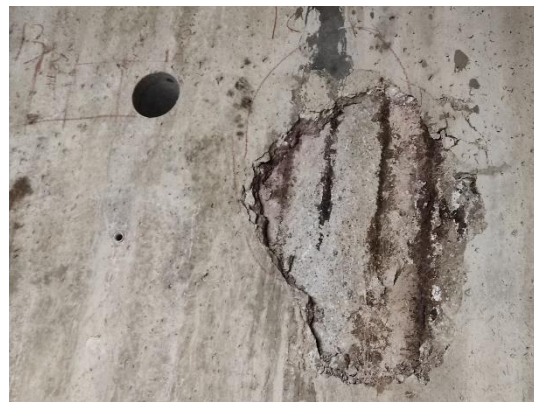
Figura 47 Humedades, manchas de óxido y desconchones en el alma en zonas bajo pasatubos
