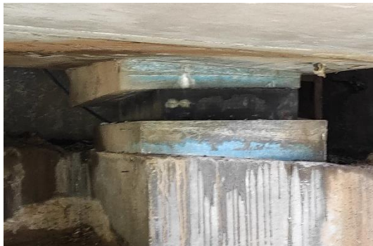
Figura 68 Aparato de apoyo reptado (Viaducto pequeño, Estribo E-2, Lateral derecho)
