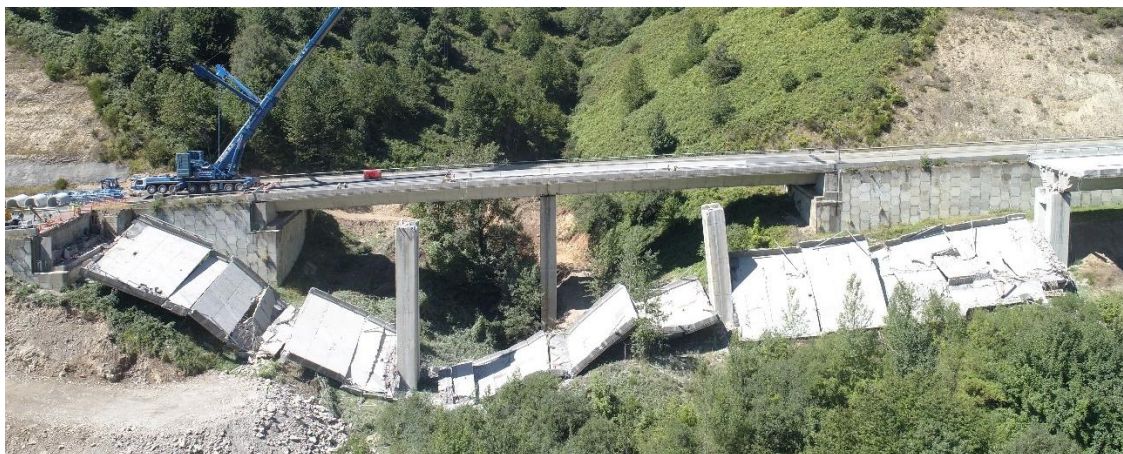
Figura 131 Vista general de los vanos V1, V2 y V3 tras la demolición del vano V2.
