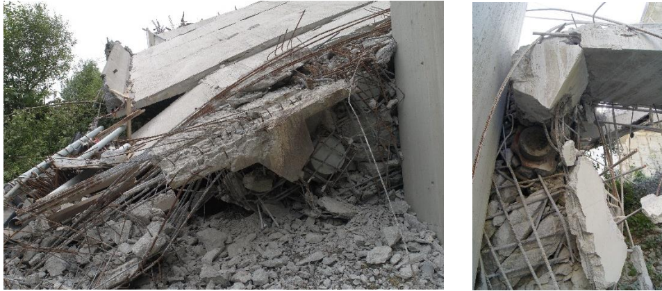
Figura 145 Vano 1. Mamparo 2. Vista frontal derecha (imagen izquierda) e izquierda (imagen derecha) desde el exterior. Apenas resulta parte del mamparo visible tanto por el propio fallo, el efecto de la caída.
