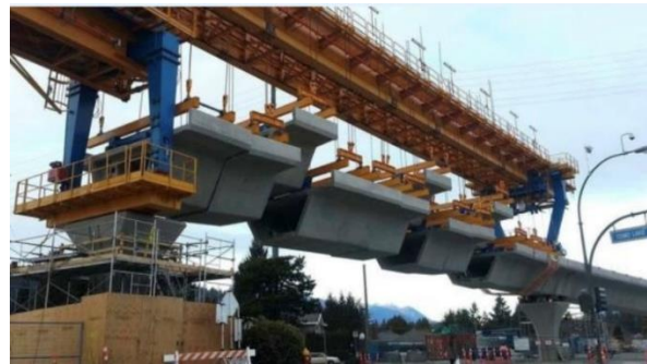
Figura 42 Ejemplos de soluciones constructivas mediante vigas lanzadoras de dovelas en fase constructiva
