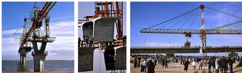
Figura 29 A la izquierda, vista general del proceso constructivo del viaducto l'Île de Ré. En el centro y a la derecha, colocación de la última dovela del viaducto en 1988.
