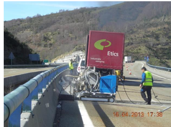
Figura 98 Vista general de los trabajos de hidrodemolición de losas de continuidad en 2013. Fuente: COPASA
