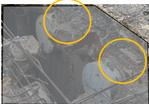
Figura 280 Detalle debloques de pretensado sobre pila P3, a la izquierda, tras picado de losa de continuidad y sobre pila P1, tras la demolición de la losa y el saneado del hormigón. A destacar la escasa distancia entre los bloques con casi 6000 kN respecto al borde superior libre. Placa de anclaje casi enrasada con el propio paramento superior de la losa. Sombreado en gris, la zona "inerte" correspondiente a las losas de continuidad (ver sección marcado en figura inferior
