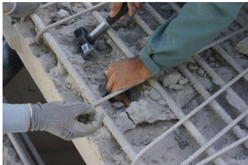
Figura 166 Vano 2. Mamparo 1. Picado manual del hormigón residual por encima de la junta fría.
