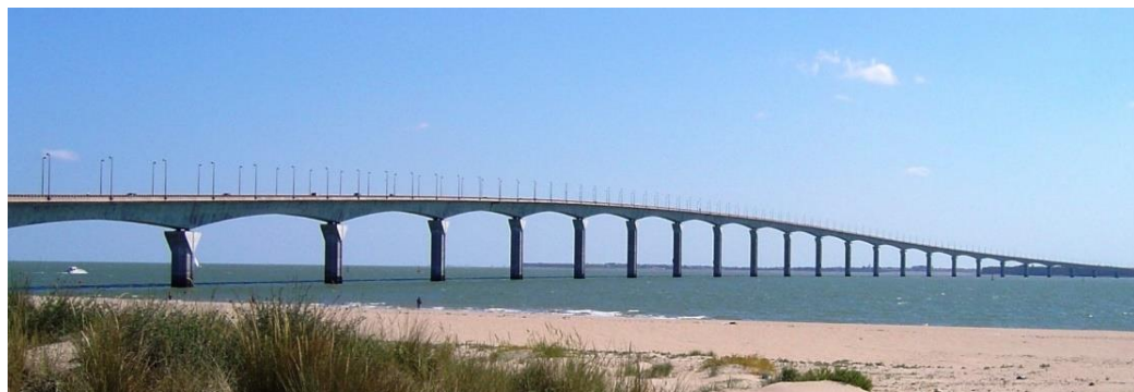
Figura 254 Vista general del puente Íle de Ré. Uno de los puentes más icónicos a nivel mundial desarrollado con postesado exterior y dovelas conjugadas allá finales de los años 80.
