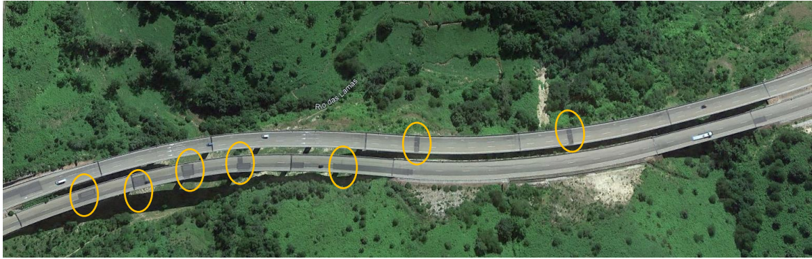
Figura 61 Vista aérea de viaductos en donde se pueden observar claramente por el reaglomerado las juntas que habían sido objeto de patología más acusada en el pasado. El resto presentaban igualmente deficiencias, si bien no tan acusadas.
