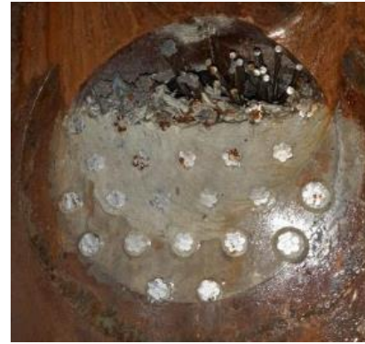
Figura 269 Detalles del interior de bloques de pretensado, con importantes defectos de protección por la lechada detectados durante la fase de "autopsia" y sustitución selectiva de 17 cables. Fuente: Freyssinet
