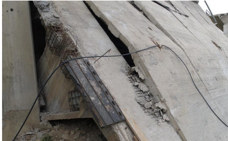
Figura 180 Vano 3. Mamparo 2. Vista general exterior desde el lateral derecho, lateral izquierdo no visible por el ocultamiento que supone el frontal de la pila P2. Aparente estado de integridad.
