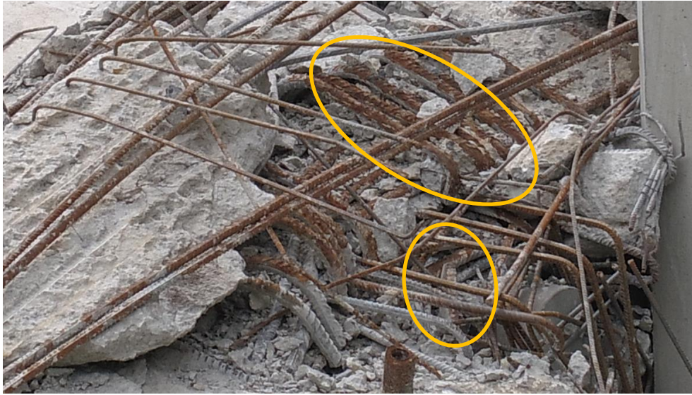
Figura 147 Vano 1. Mamparo 2. Ídem.
