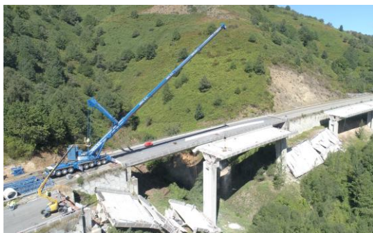
Figura 121 Vista general de la demolición
