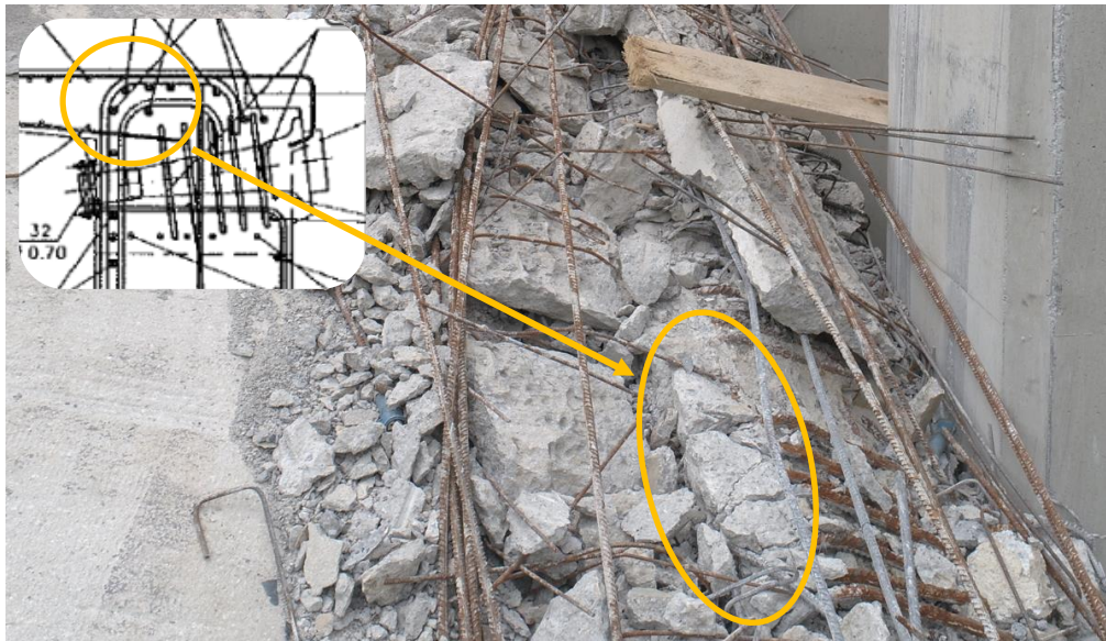
Figura 152 Vano 1. Mamparo 2. Vista superior de cabeza de mamparo desde el lateral derecho. Fragmentos de losa, en prolongación de mamparo sobre dovela D15. Pendientes de identificar, si bien parecería que pertenecen a la parte de dovela del mamparo.
