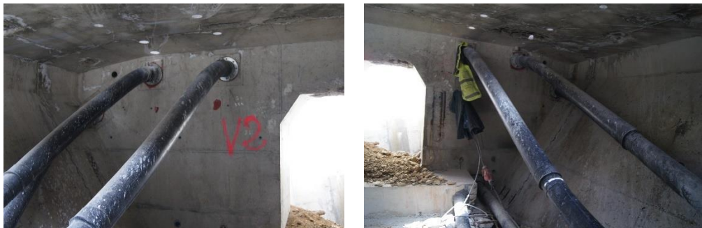
Figura 174 Vano 2. Mamparo 1. Vista general del interior del mismo. Aparente integridad estructural del mismo y sin grandes desórdenes a simple vista.
