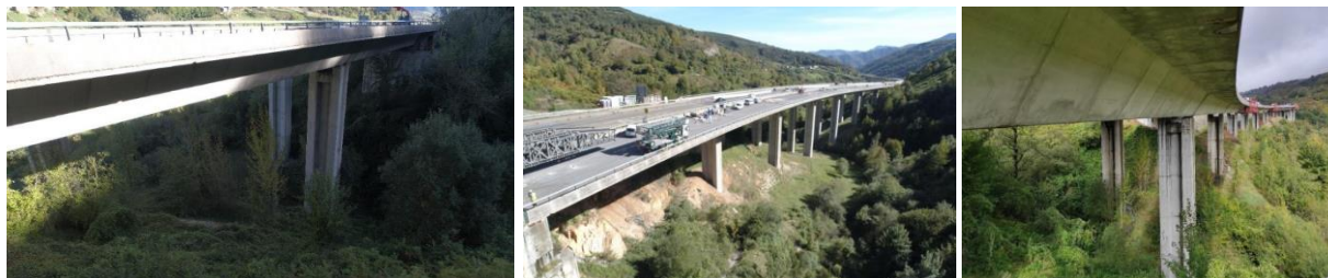
Figura 8. Vista general del viaducto pequeño (izq.), mediano (cent.) y grande (der.). (Fuente: [5]).
