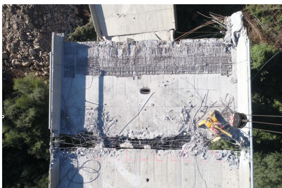
Figura 57. Proceso de demolición del vano 2.
