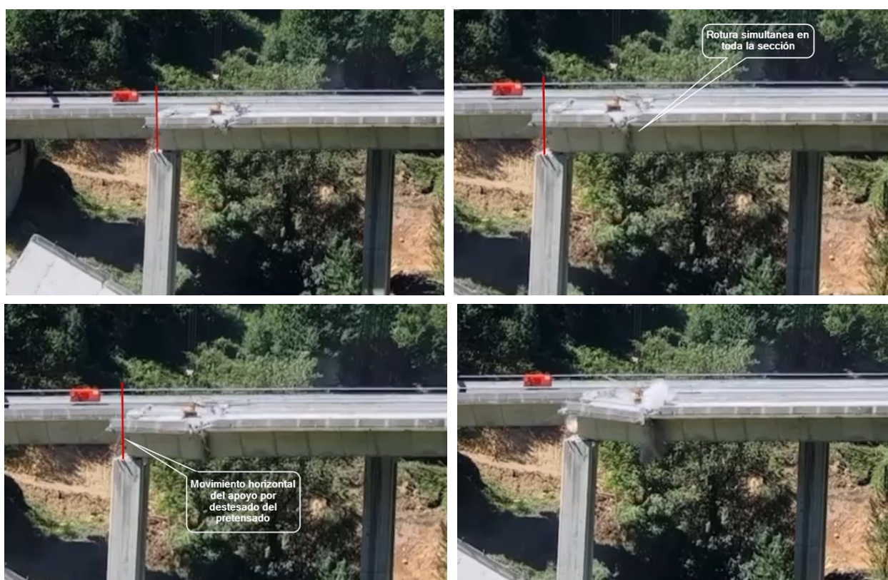
Figura 58. Proceso de caída del vano 2.
