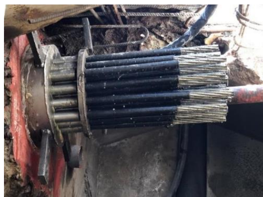
Figura 26. Operación de corte de los cables existentes (izq). Enfilado de cables nuevos (der). (Fuente: [5]).
