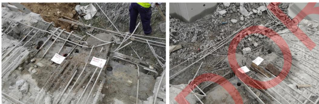
Figura 10. Localización de zonas de extracción de testigos sobre el mamparo 1 del vano 2
