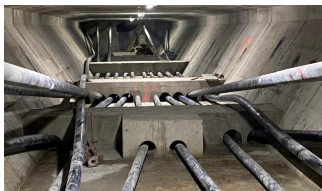
Figura 25. Alzado y sección de los nuevos cables de pretensado en el mamparo (izq). Imagen del interior del cajón con los cables de refuerzo instalados (der). (Fuente: [5]).
