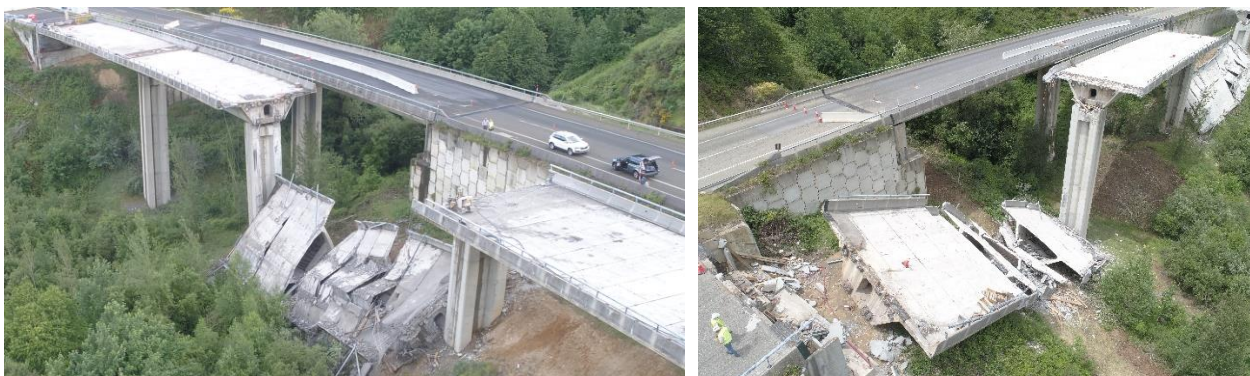
Figura 1. Colapso del vano 3 del viaducto de la calzada sentido A Coruña. Colapso del vano 1. (Fuente: [5])
