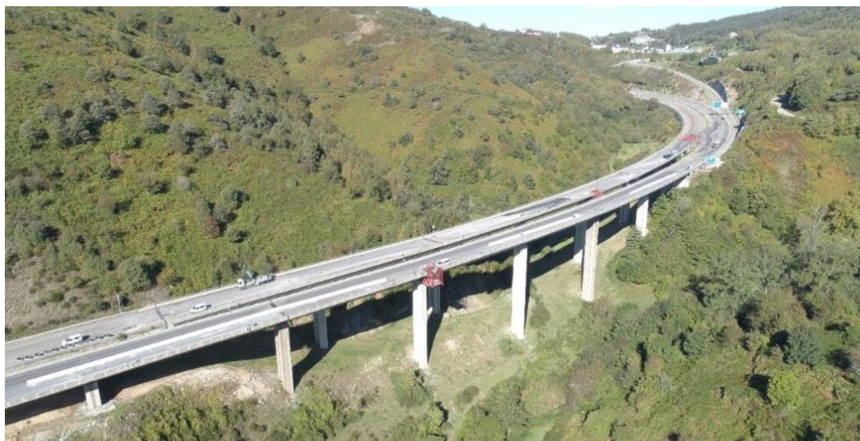
Figura 7. Vista general de los viaductos del Castro. En primer término, el viaducto mediano y el final del viaducto grande. Al fondo, Piedrafita del Cebreiro. (Fuente: [5]).
