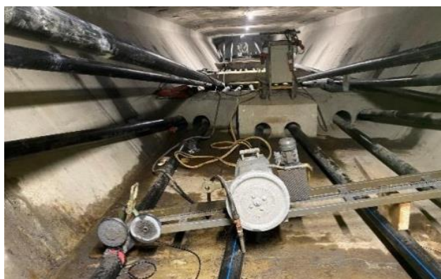
Figura 26. Operación de corte de los cables existentes (izq). Enfilado de cables nuevos (der). (Fuente: [5]).
