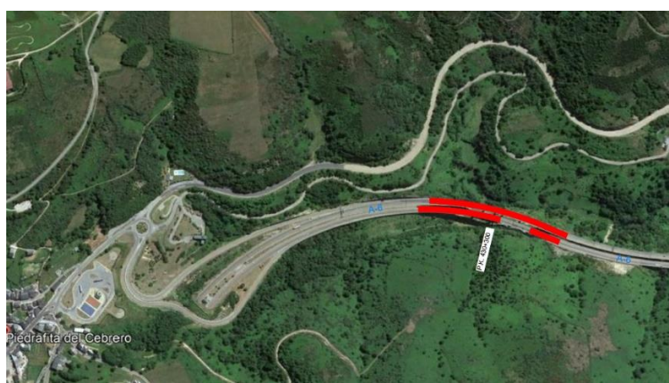
Figura 5. Localización de los viaductos del Castro en la autovía A-6. (Fuente: [5]).
