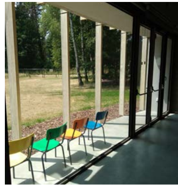
Buiten aangebrachte zonwering is efficiënter dan zonwering binnen
